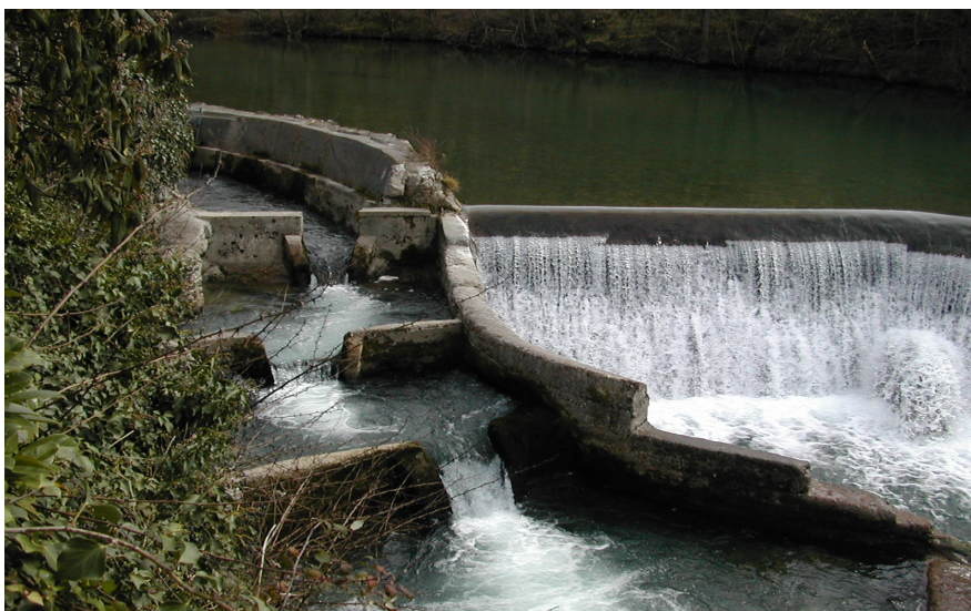
Photographie 7.52 : Passe à poissons de construction rustique
