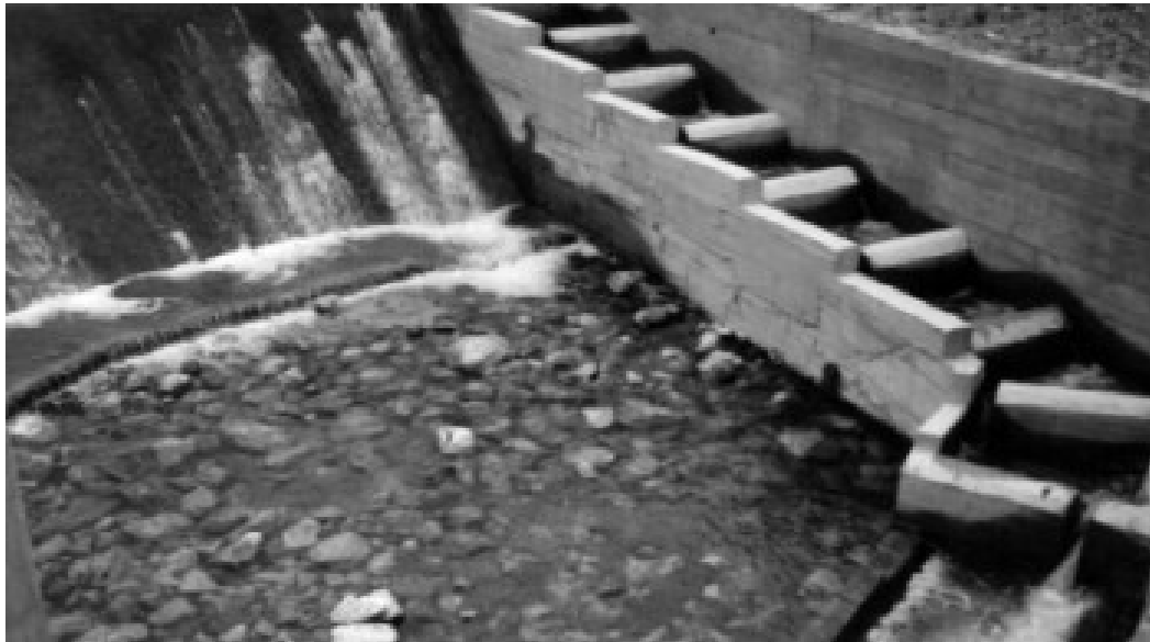
Figure 7.125 : Passe à poissons à chicanes
