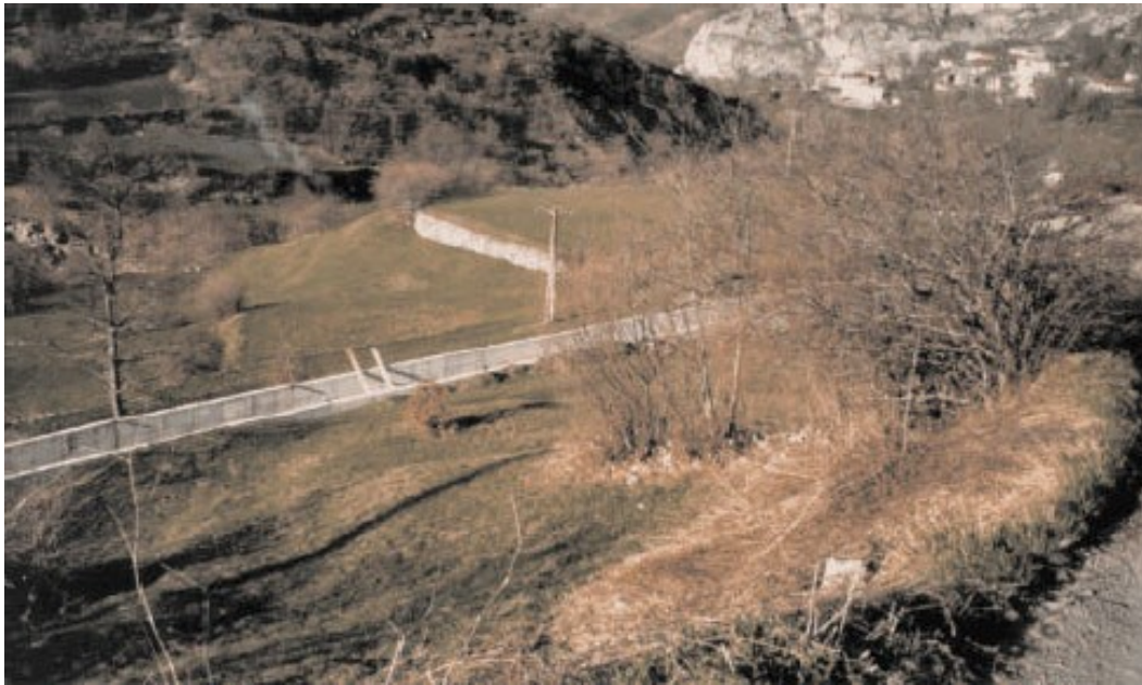
Photographie 7.45 : Phase de construction – canal en béton
