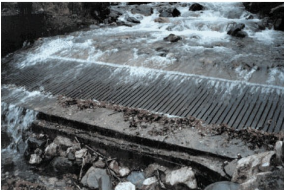
Photographie 5.20 : Prise d'eau par en dessous
