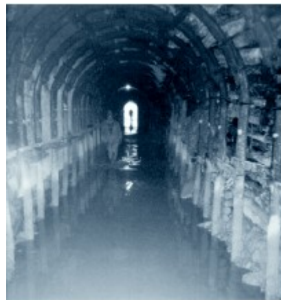
Photographie 4.7 : Vue de la galerie en travaux
