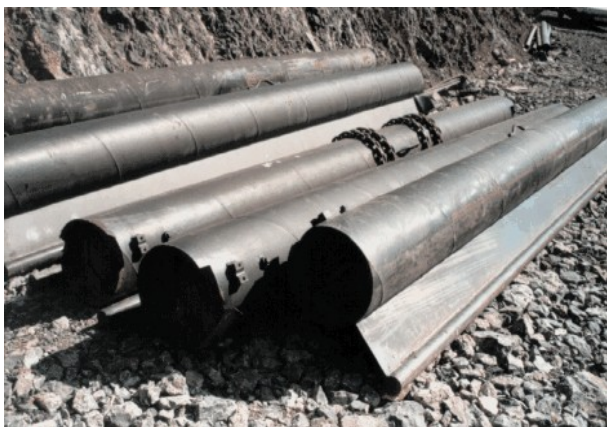
Photographie 5.21: Dromes préfabriquées
