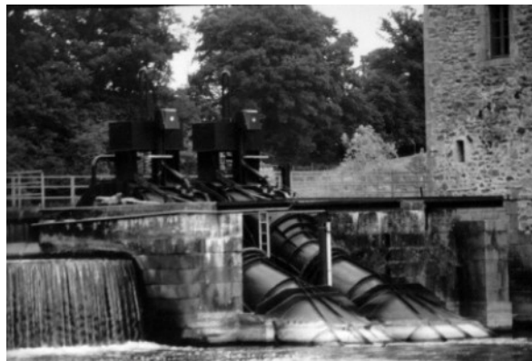
Photographie 6.39 : Vue de turbines Kaplan en siphon
