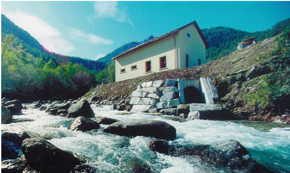
Photographie 6.33 : Vue d'ensemble d'une petite centrale typique
