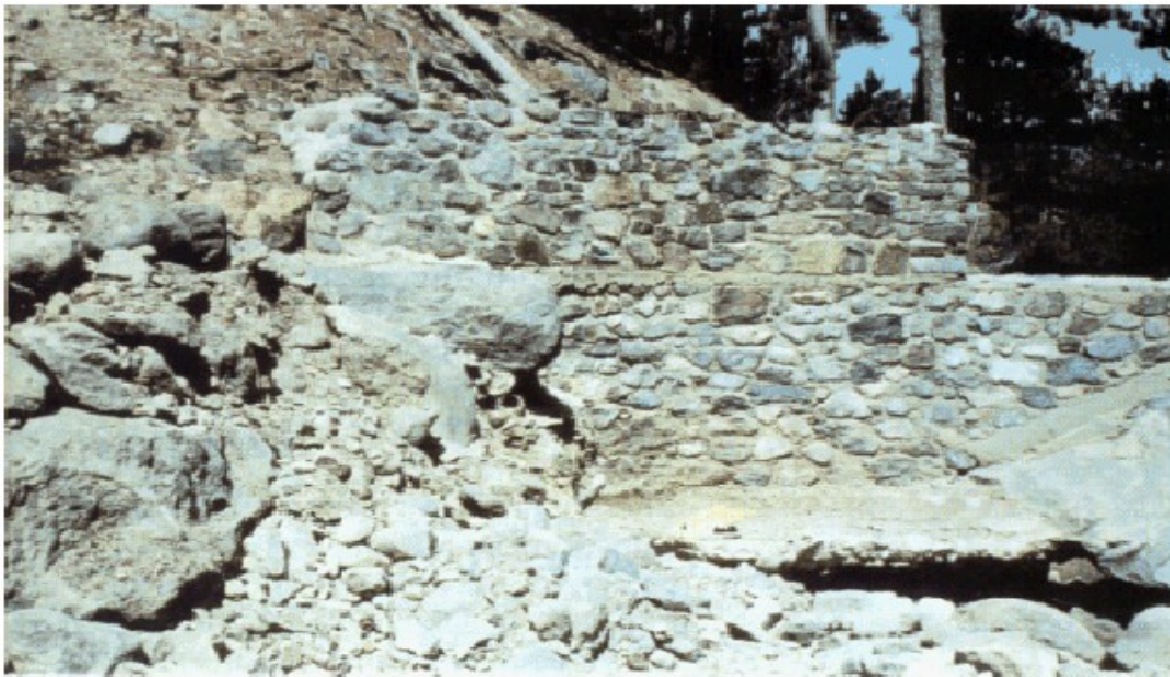
Photographie 4.13 : Seuil affouillé par des infiltrations
